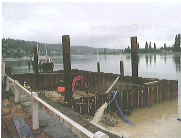
Les travaux d'août
