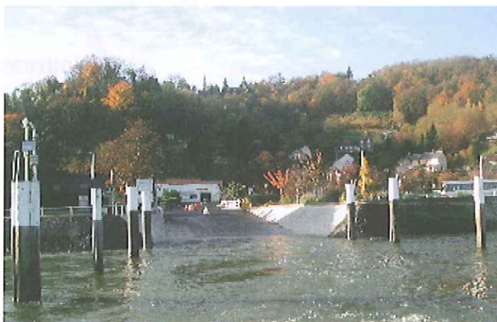
La cale terminée vue de la Seine
