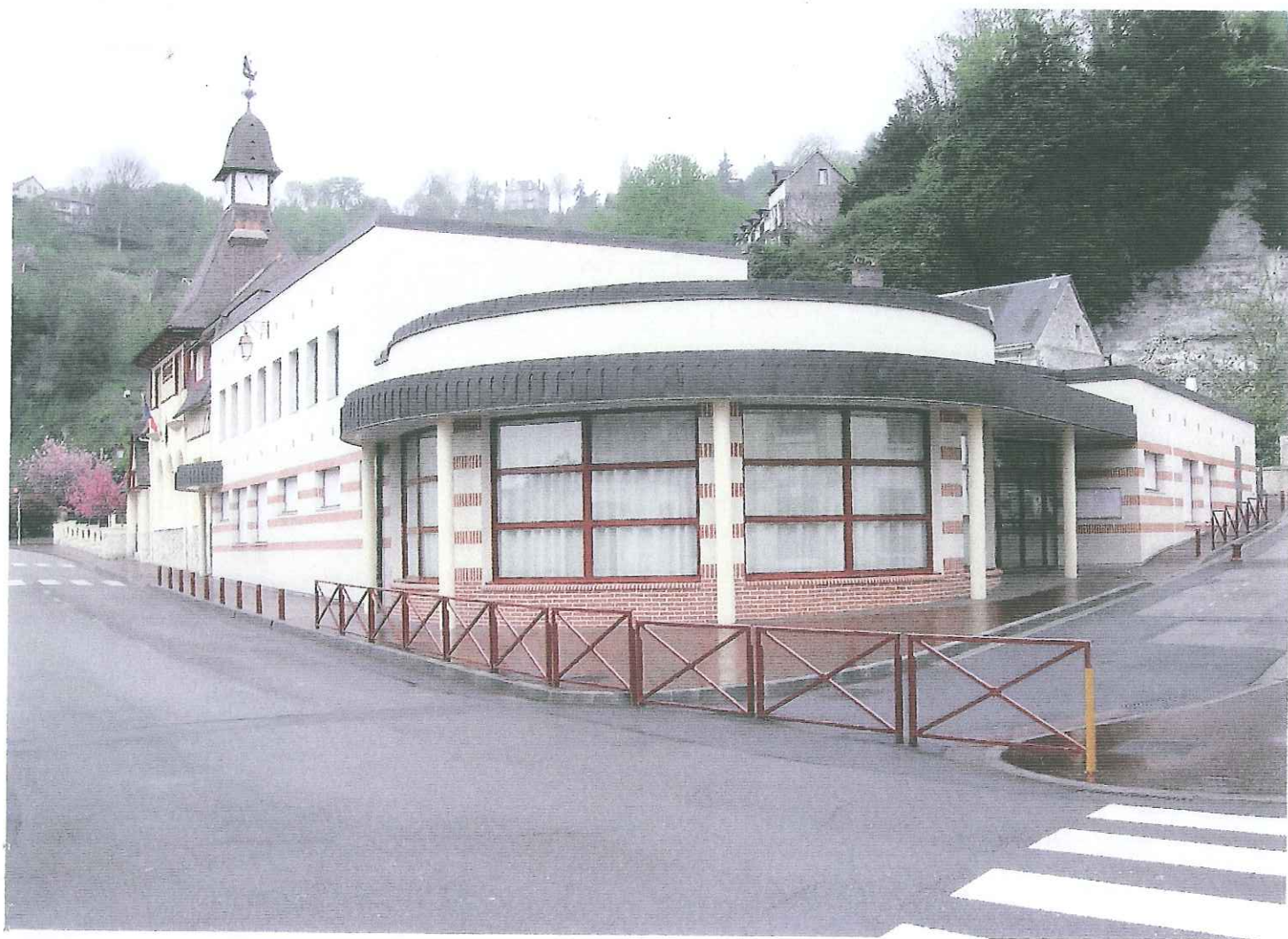
Le nouveau groupe scolaire
