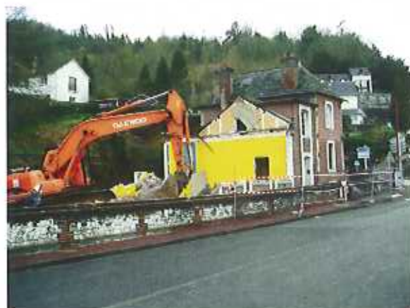
Le démarrage des travaux
