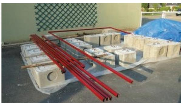
Certaines bâches seront fixées sur des portiques, ancrés dans des pieds en béton, en cours de fabrication.
